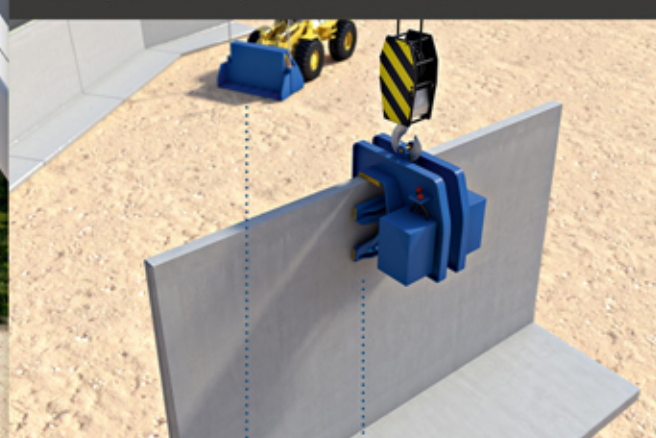
PLAATSING KEERWANDEN MIDDELS MECHANISCHE KLEM VOLGENS DE LAATSTE KLEM(VERHUUR)VOORSCHRIFTEN
